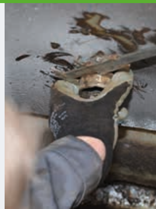
► Kürzen des Druckabgangs im Schacht
