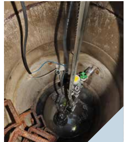
Eingebaut: Einbauset DN 40 Single
