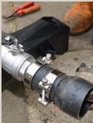
Anpassen der elast.Verbindung
