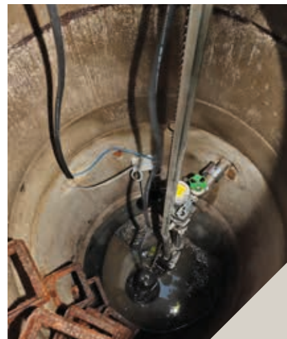
Eingebaut: Einbauset DN 40 Single
